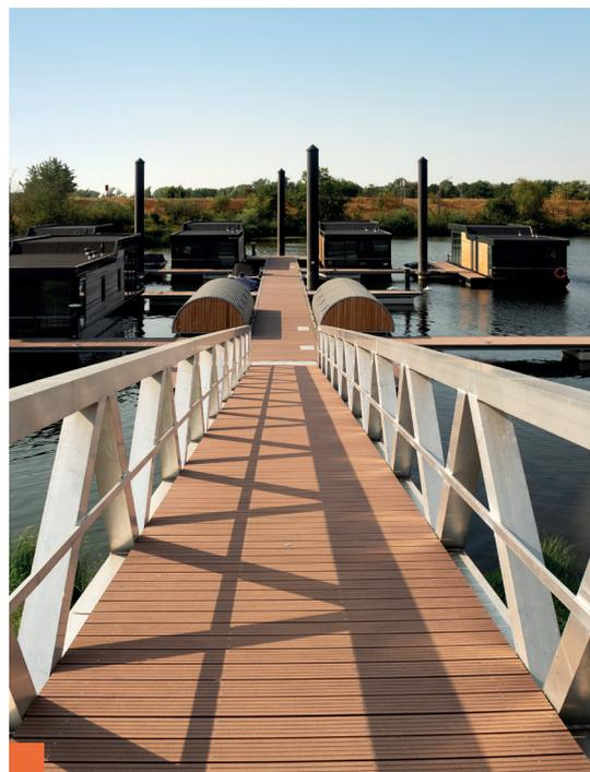
**Der Composite Volkernbelag besteht zu 70 % aus PEFC-zertifiziertem Holz und einem umweltfreundlichen Polymer. Es handelt sich um solide Decksteile, die leicht zu warten sind. Der Bodenbelag ist außerdem splitterfrei, barfußfreundlich und rutschfest, auch wenn das Material nass ist. Die Oberfläche ist gebürstet. Das Material ist vollständig recycelbar.**
